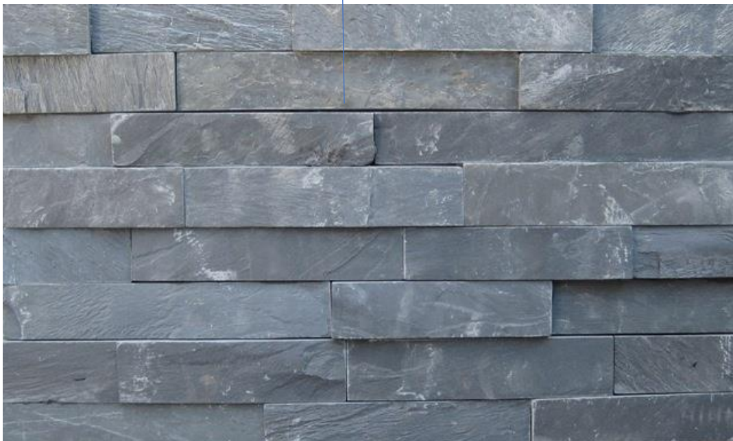
De natuurstenen worden hergebruikt van een trap in het afgebroken gedeelte van Het Alfa college.
