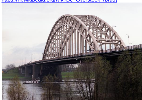
De Waalbrug (oude Waalbrug)
